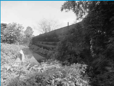
คันดินและร่องน้ำกั้นระหว่างแนวเขต ของฟาร์มกับลำรางสาธารณะ
