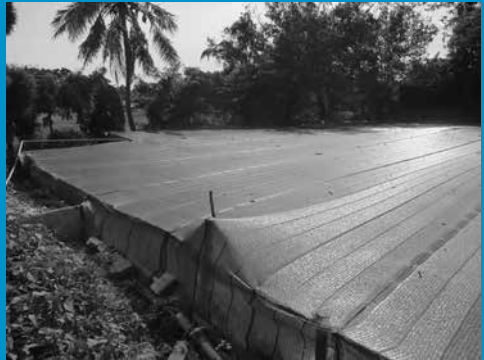
การปิดคลุมบ่อพักน้ำเสีย
