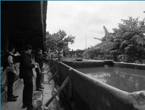
บ่อบำบัดน้ำเสีย
